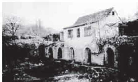
Foto nr. 2, AIEF F.L. 1712-8: Locuințe construite pe zidul cetății.
